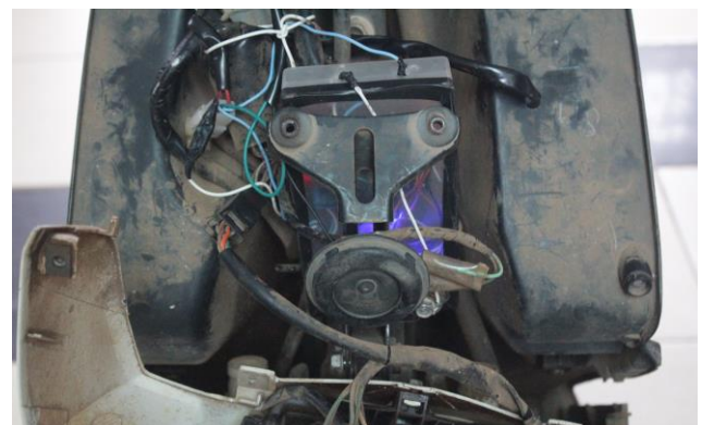
Gambar. 10. Instalasi Smart Motor pada body motor
