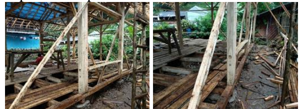
Gambar 13. Pekerjaan Pemasangan Reng, Pemasangan Lantai dan Pemasangan Dinding
