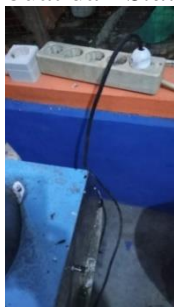
Gambar 13. Pengoperasian Alat Cukup dengan Menancapkan Kabel Alat pada Power Supply
