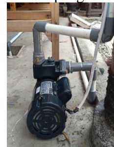
Gambar 6. Pemasangan Pompa Otomatis
