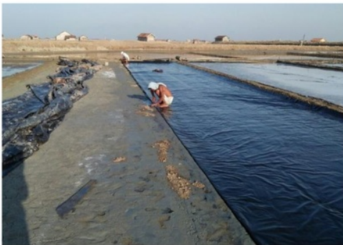
Gambar 5. Proses Pemasangan Geomembrane oleh UKM Mitra
