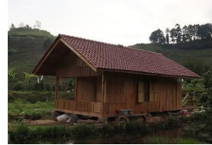
Tampak Samping Bangunan
