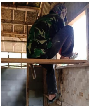
Gambar 11. Tahapan Lanjutan Pemasangan Dinding
