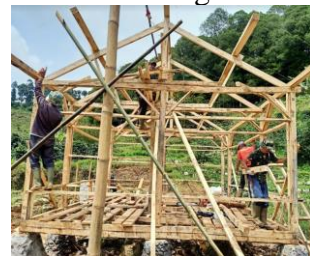
Gambar 6. Tahapan Perakitan Komponen Struktur Utama Kolom dan Balok
