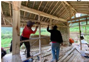
Gambar 10. Tahapan Pemasangan Jendela dan Pintu
