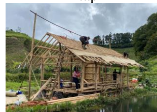
Gambar 8. Tahapan Pemasangan Genteng
