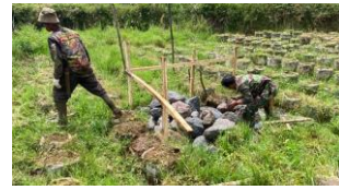
Gambar 3. Tahapan Persiapan Pembuatan Pondasi
