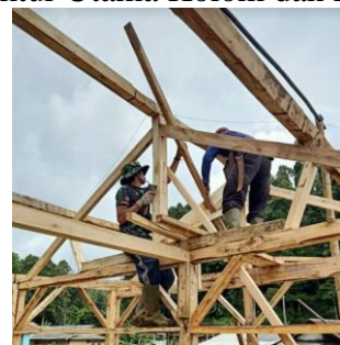
Gambar 7. Tahapan Pemasangan Konstruksi Atap
