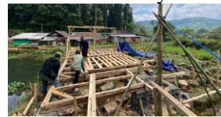
Gambar 5. Tahapan Pemasangan Papan Lantai Bangunan
