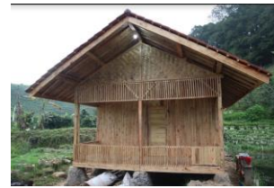
Tampak Depan Bangunan
