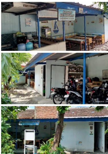
Gambar 1. Dokumentasi Kondisi Kantin
