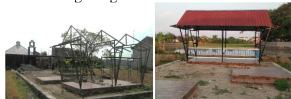
Gambar 11. Pemasangan produk hasil desain menggunakan program CAD berupa Gazebo di Masjid Fatima Ar-Royan.
