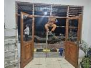
Gambar 4. 12 Pintu dengan 2 daun pintu di bangunan Stasiun Plabuan
