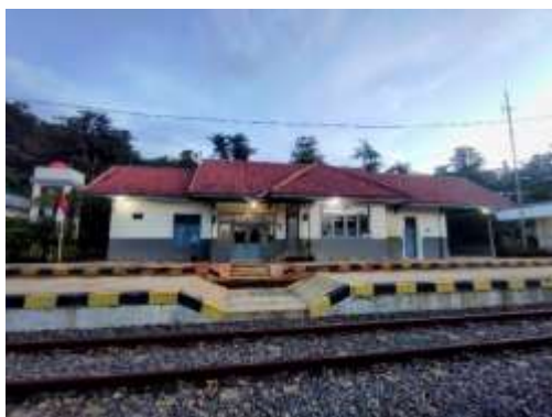
Gambar 4. 8 Peron pada Stasiun Plabuan
