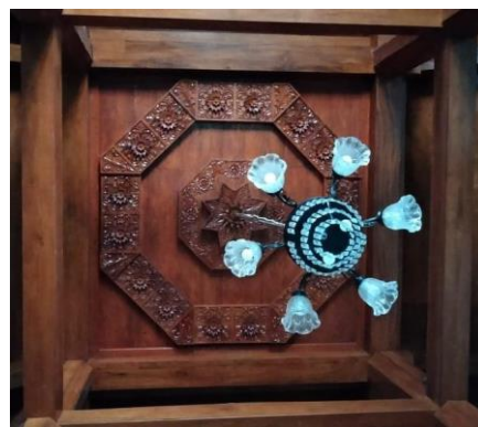
Gambar 8 Tumpangsari pada Masjid Jami' Sunan Abinawa pada bagian dalam
