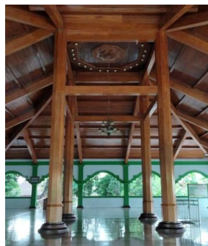
Gambar 3 4 pilar kayu jati pada Masjid Jami' Sunan Abinawa pada bagian luar
