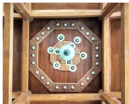
Gambar 7 Tumpangsari pada Masjid Jami' Sunan Abinawa bagian luar
