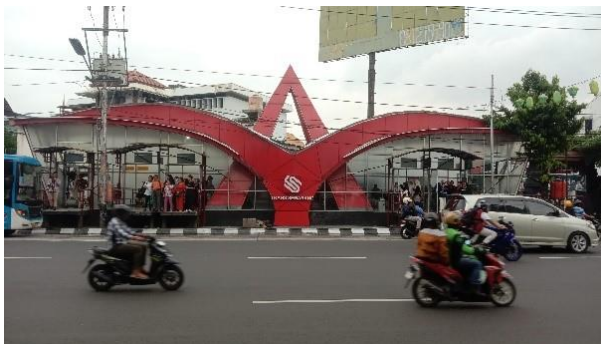
Gambar 2. Tampak Depan Halte Sumber : Dokumentasi Pribadi
